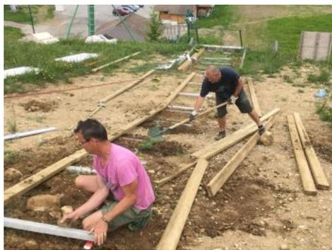
Cette structure de 3 rangées de poutrelles permet maintenant de recevoir les plaques portant les rails de lancement.
